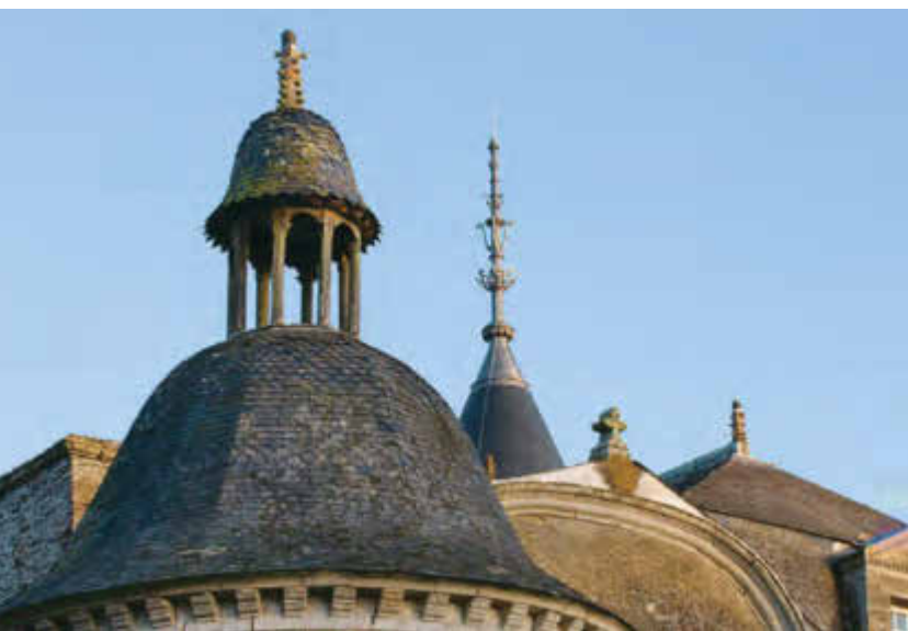
Vue des toits du château de la Bourbansais à Pleugueneuc (Ille-et-Vilaine)
