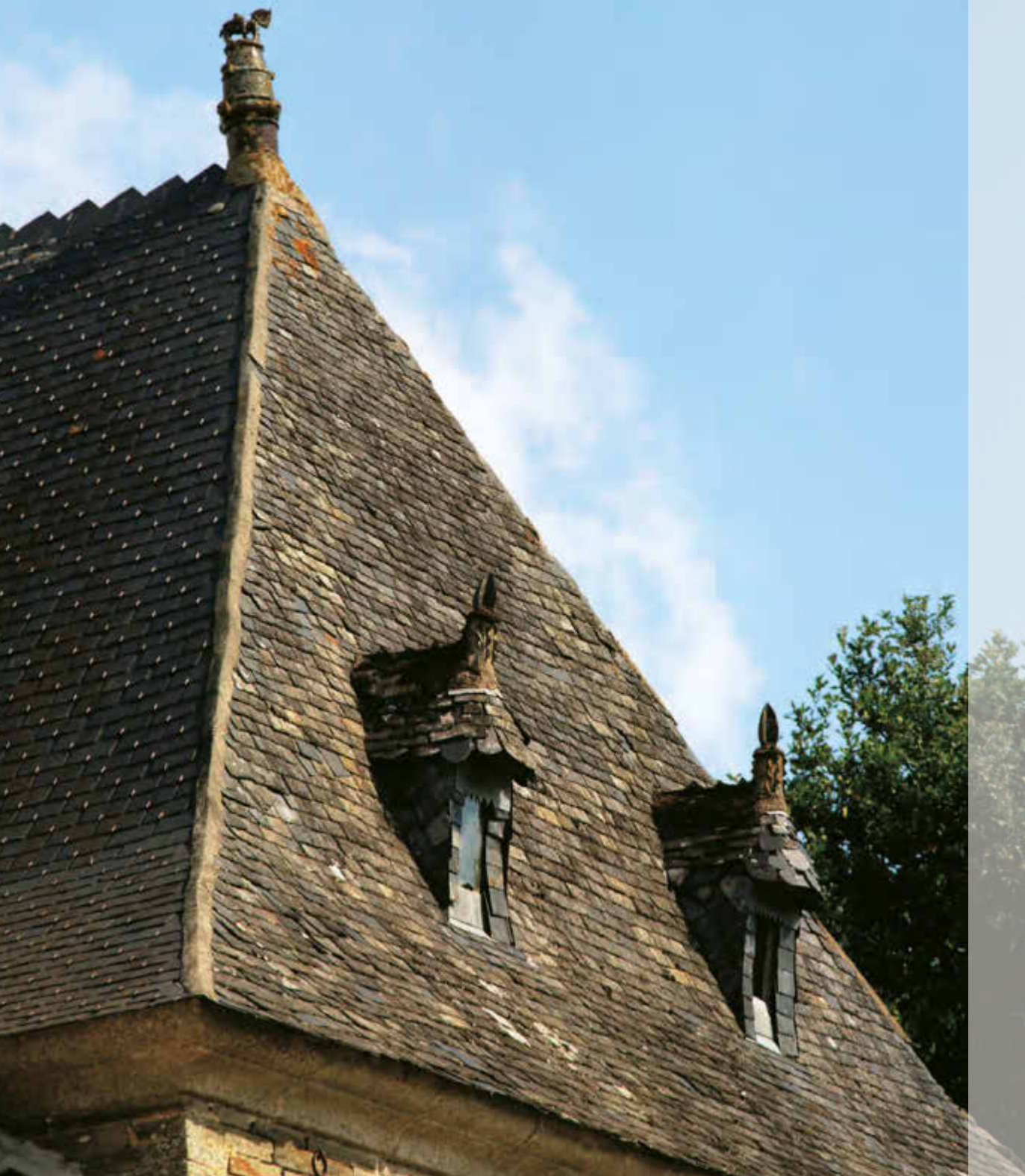
Toiture du manoir de la Ville aux Veneurs à Trévé, XVIII e siècle (Côtes-d'Armor)
